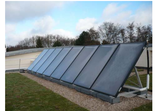
Panneaux solaires thermiques plan en toiture terrasse. Source TRANS-FAIRE
