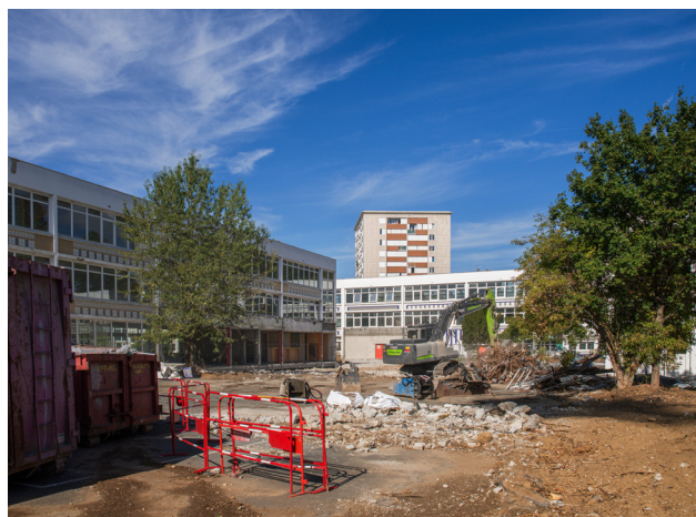
Travaux en cours au groupe scolaire Henri-Wallon
