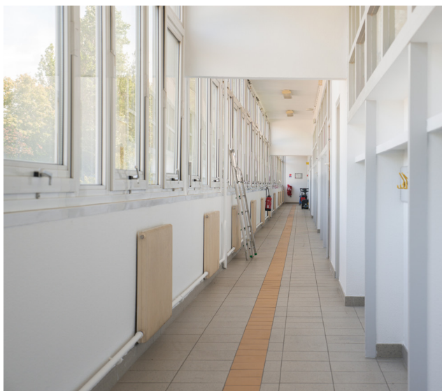
Travaux de peinture à l'école Diderot A
