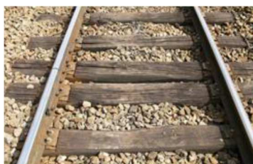
Rails courts sur traverses bois
