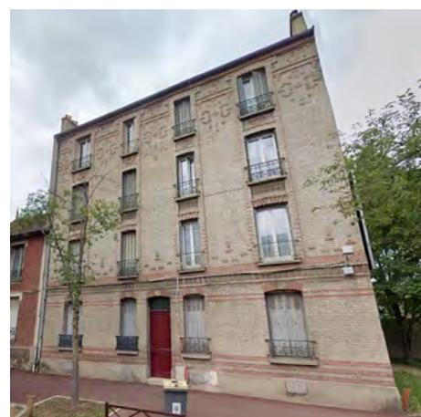
Immeuble de 3 étage avec un rdc surélevé, en parement briques et de motif en relief. L'ordonnement de la façade par des fenêtres régulières avec persienne. En alignement sur la rue.
