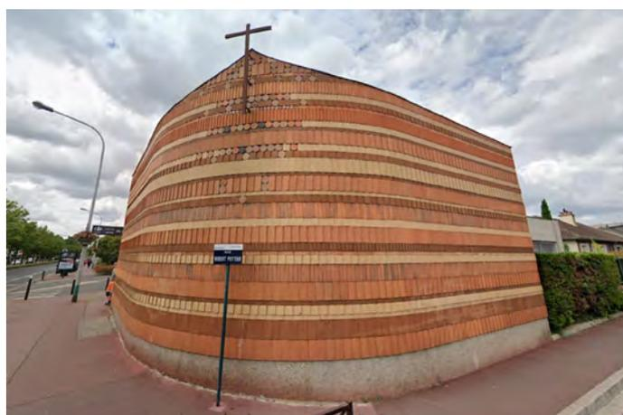
C'est un édifice plat, d'apparence sobre avec une abside en angle arrondi, accolée à la salle servant de nef. Son mur est percé de petites fenêtres carrées en hauteur. Le volume est en béton, avec un parement extérieur en briques.
