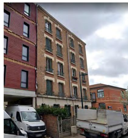
Immeuble en brique, linteau en enduit clair ton pierre, en recul de la voirie, un petit jardinet, clôture en béton avec soubassement et trame verticale
