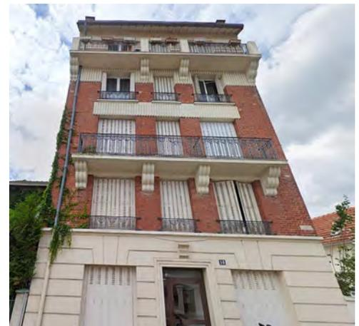
En alignement à l'espace public, rez-de-chaussée et décoration en béton en structure pierre, 4 étage en parement brique, deux balcons filants.
