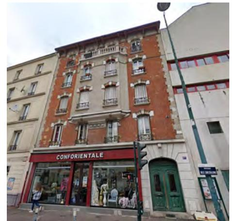
Immeuble de logements R+4 en parement brique avec décor et couleur des briques, partie en surplomb à partir du R+2, rdc commerces, alignement à la rue.
