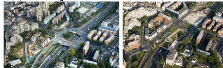
Franchissement d'une grande infrastructure : couverture du périphérique parisien et création d'un square Porte des Lilas (photos avant/après)
