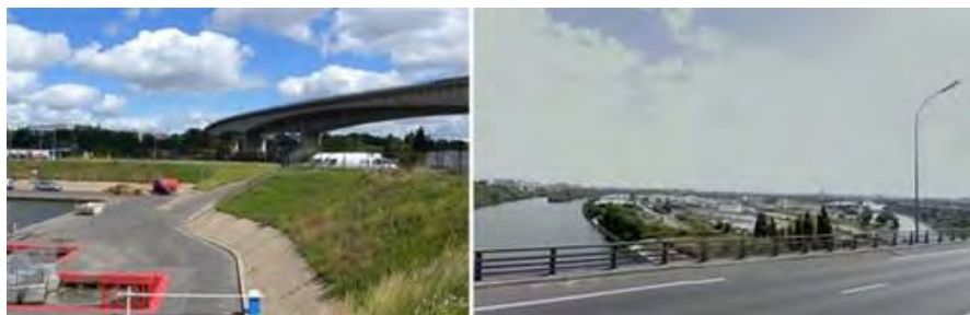
Photo 4. Viaduc de l'A15
