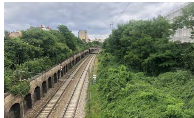
Photo 6. Ligne ferrée à Bois-Colombes (Urban-Eco, 2022)
