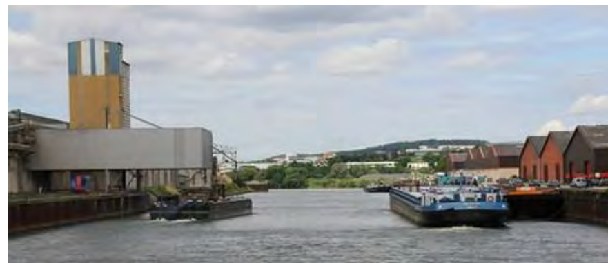
Photo 3. Vue de la darse du Port de Gennevilliers vers la butte d'Orgemont
