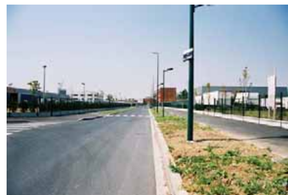
Rue des Caboeufs entre la voie ferrée et l'A15 où la voirie et ses abords ont reçu un traitement plus soigné
