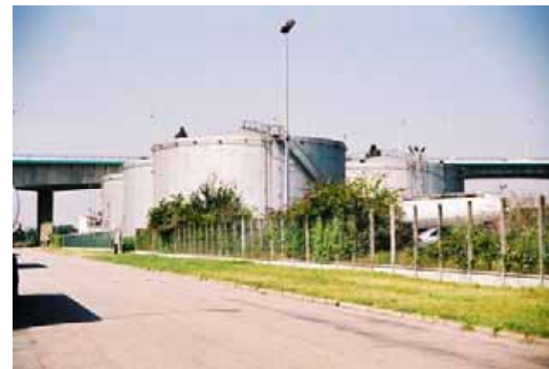
Une vaste aire de stockage, le port pétrolier. Au second plan, le viaduc de l'A15
