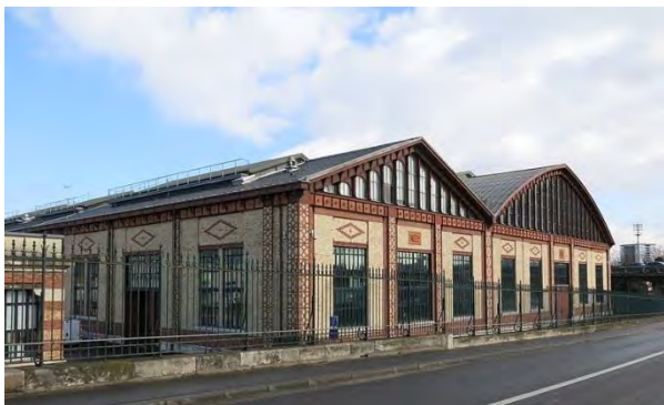
Usine élévatrice des eaux – Colombes
