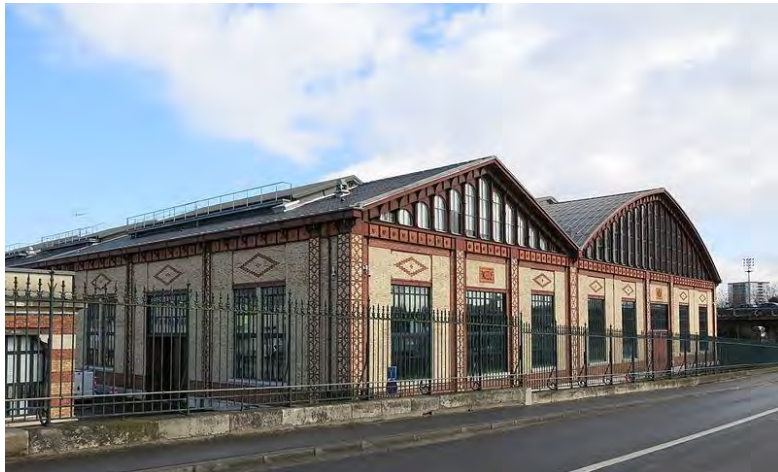
Usine élévatrice des eaux - Colombes
