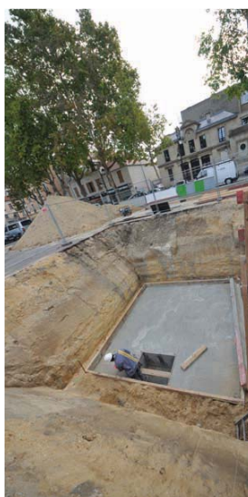
Impressionnants travaux de terrassement, d'implantation de bacs pour l'installation de la fontaine.
