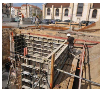
Impressionnants travaux de terrassement, d'implantation de bacs pour l'installation de la fontaine.
